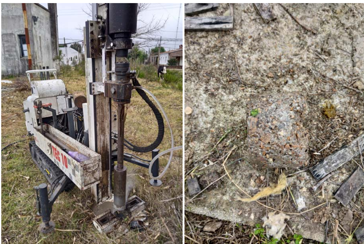
Figura 2. Perforación y extracción de hormigón en las zonas existente
